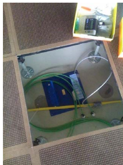
Einzug und Anschluss der Kommunikationsverkabelung Kat.6 Links für die 230 Links mit einer Kabellänge von über 12'000 Meter
