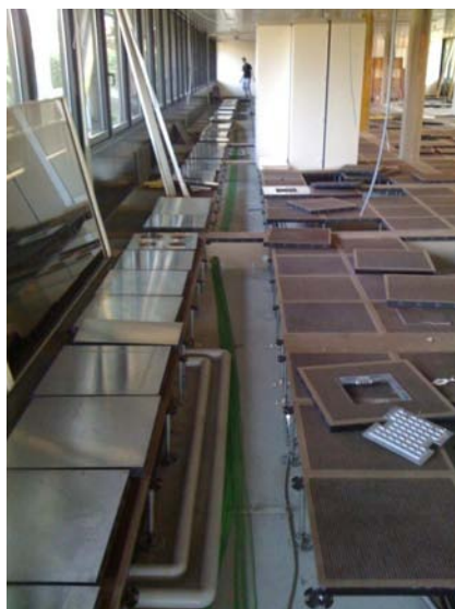
Einzug und Anschluss der Kommunikationsverkabelung Kat.6 Links für die 230 Links mit einer Kabellänge von über 12'000 Meter
