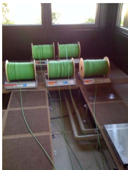
Einzug und Anschluss der Kommunikationsverkabelung Kat.6 Links für die 230 Links mit einer Kabellänge von über 12'000 Meter
