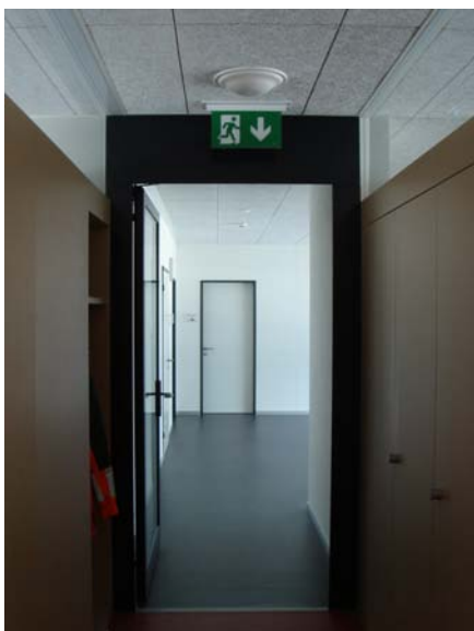
Antenne im Korridor des Bürogebäudes
