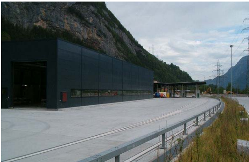
Das Hauptgebäude beim Scherverkehrszentrum in Erstfeld
